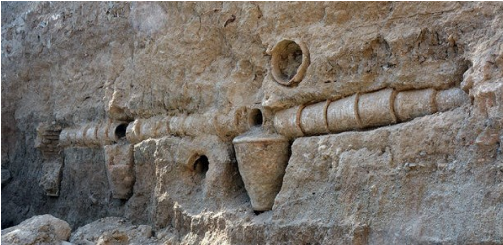
شکل ۸: نمونه ای از استفاده از تیبوشه در سیستم آبرسانی قدیمی شهر بروجرد (عکس از خبرگزاری مهر)
